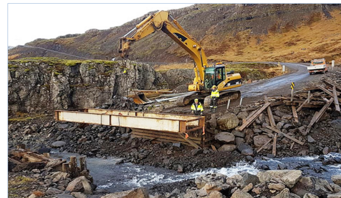
Axarvegur (939), brú á Hemru endurnýjuð, 17. nóvember 2018.
