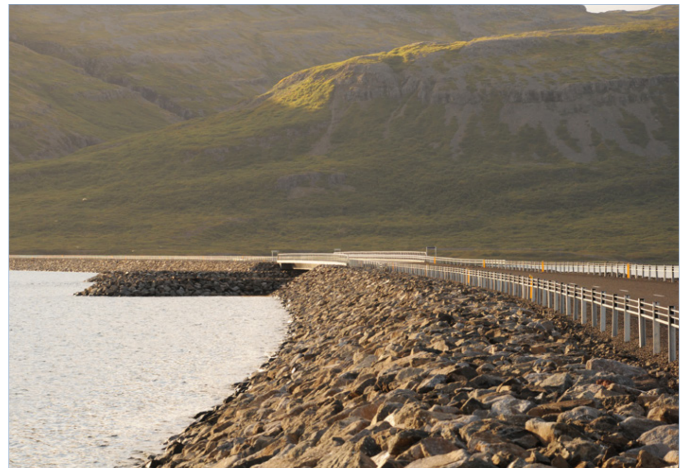
Vestfjarðavegur (60), vegfylling og brú í Kjálkafirði.
