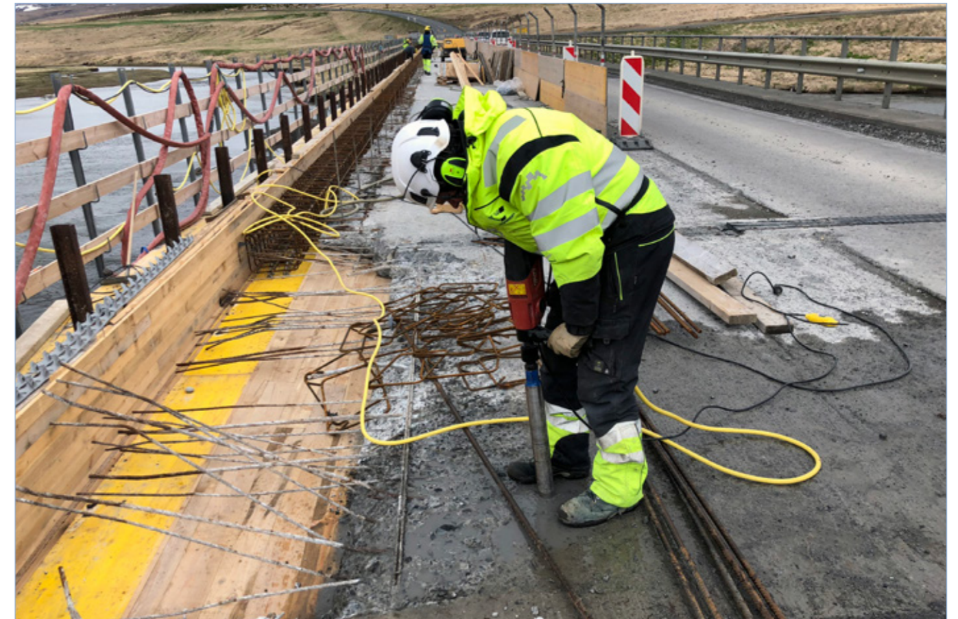
Hringvegur (1), brú á Miðfjarðará, viðgerð, 22. maí 2018.
