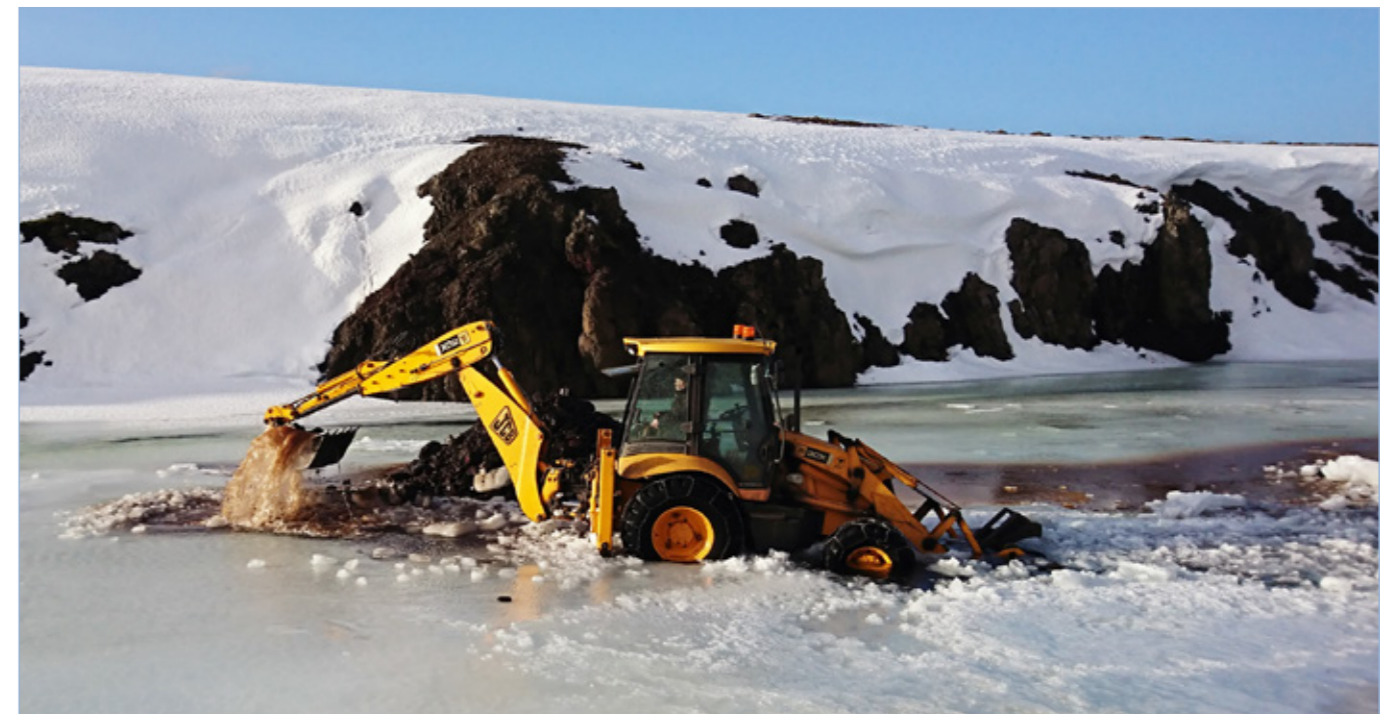
Vatnsnesvegur (711) um Tjarnará, jarðvegsrannsóknir fyrir framkvæmdir, 20. febrúar 2018.
