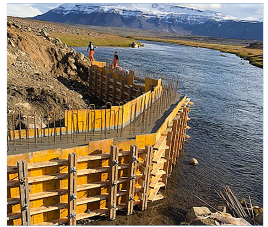
Arnarvatnsvegur (578), brúargerð á Norðlingafliót.
