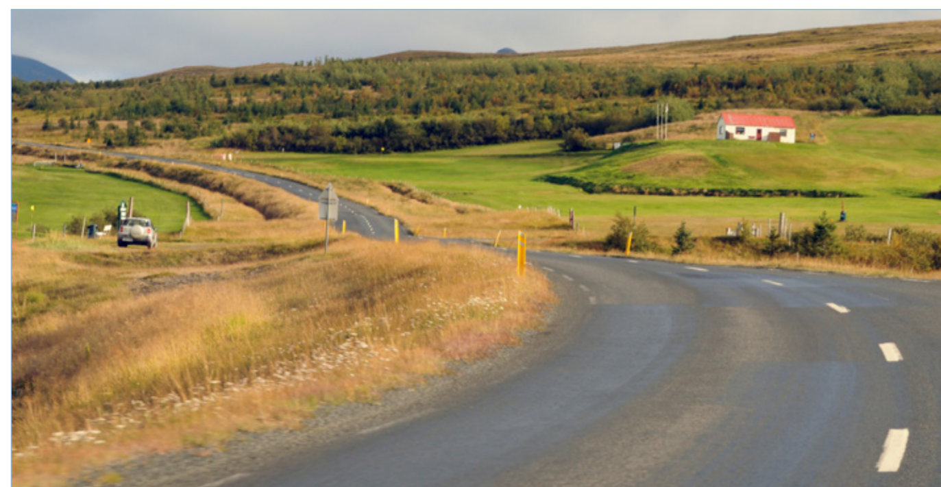
Skagastrandarvegur (74), Hringvegur – Þverárfjallsvegur. Breytt og betra vegstæði hefur verið í undirbúningi undanfarin ár.
