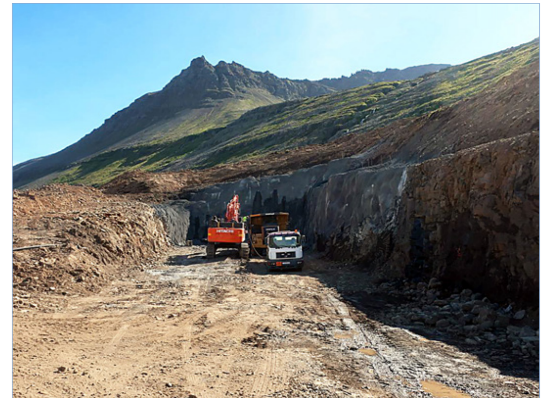
Dýrafjarðargöng forskering í Dýrafirði, 11. ágúst 2018.
