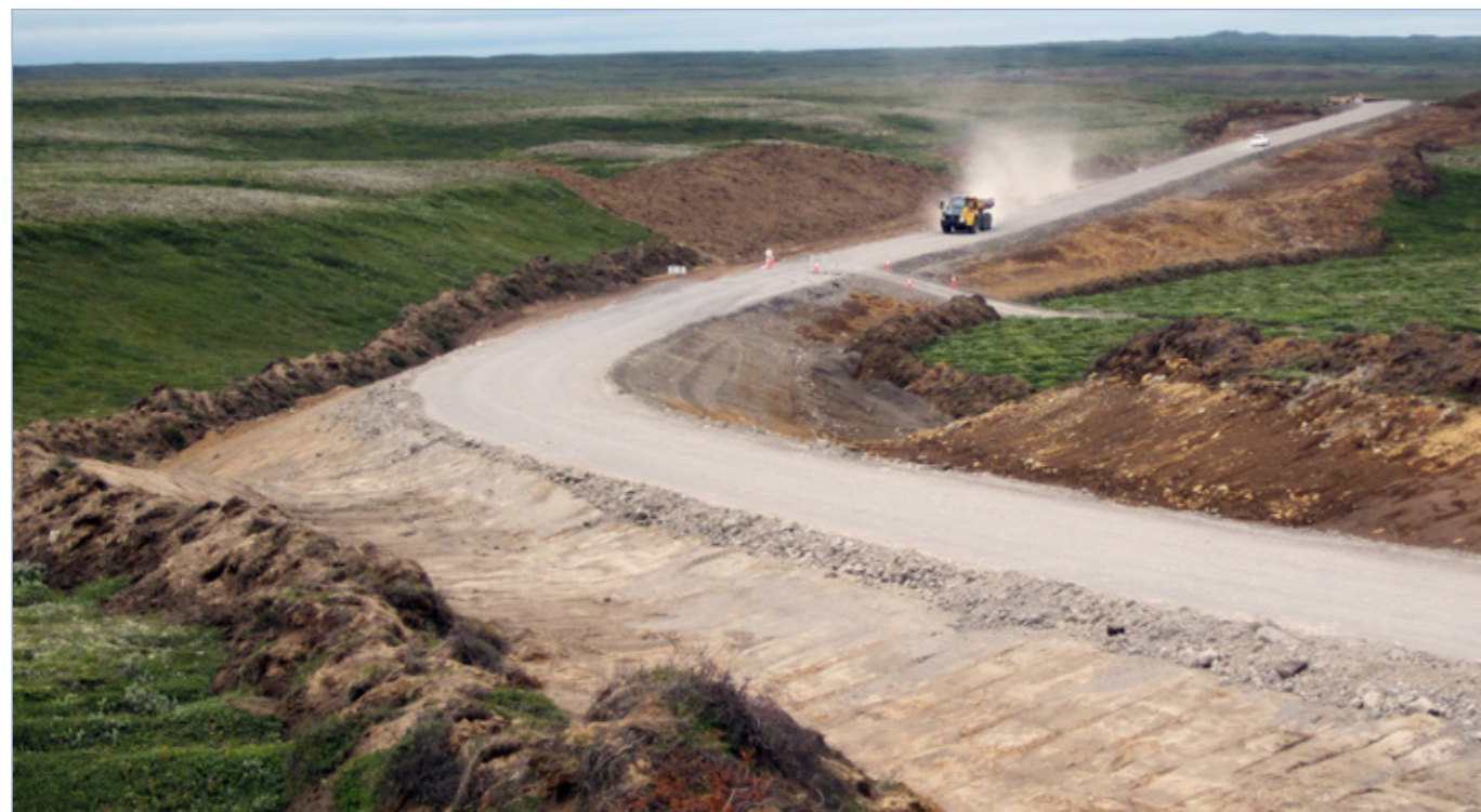
Dettifossvegur (862), svarflag bíður þess að vera lagt í vegfláa, 19. júlí 2018.
