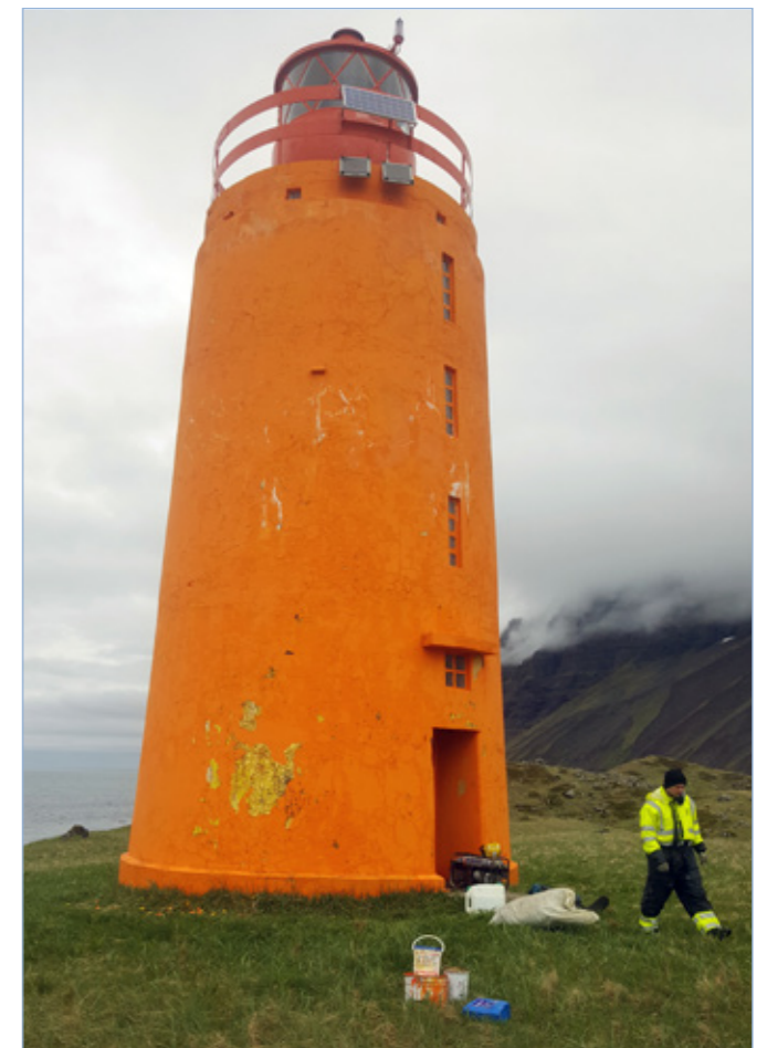
Fjallaskagaviti, norðanvert við mynni Dýrafjarðar, viðhaldsvinna, 10. júní 2018.
