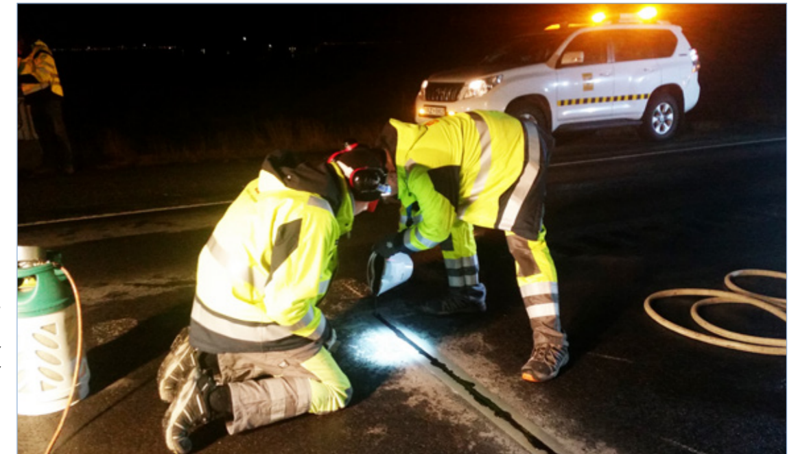
Umferðaröryggi, sjálfvirk hraðaeftirlit. Mælistaður settur niður 3. október 2018.
