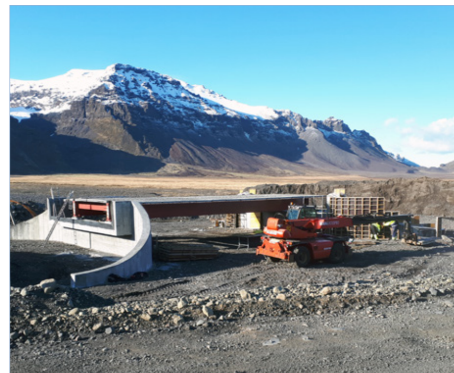
Hringvegur (1), brúargerð á Stigá, 2. maí 2018.
