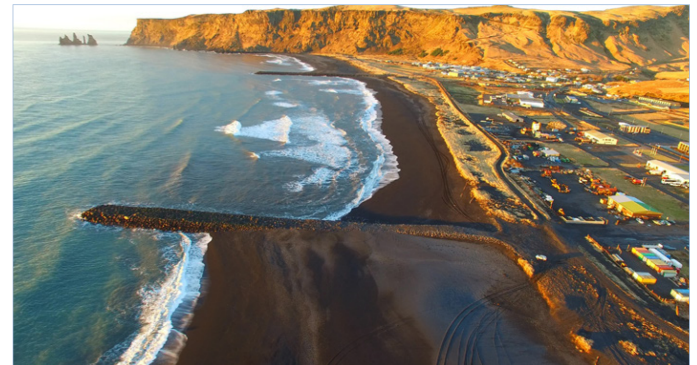
Sandfangarar við Vík í Mýrdal, 21. desember 2018. Ljósmynd Þórir N.K.
