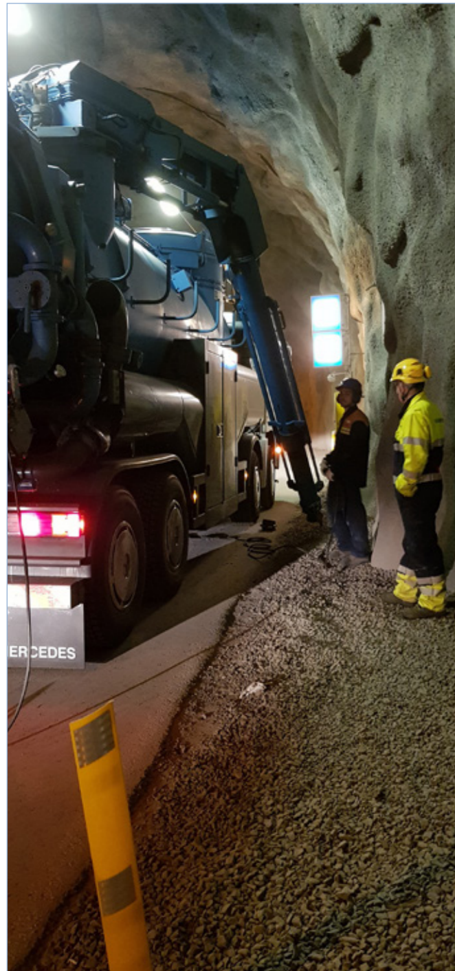
Fáskrúðsfjarðargöng, viðhaldsvinna, 23. maí 2018.
