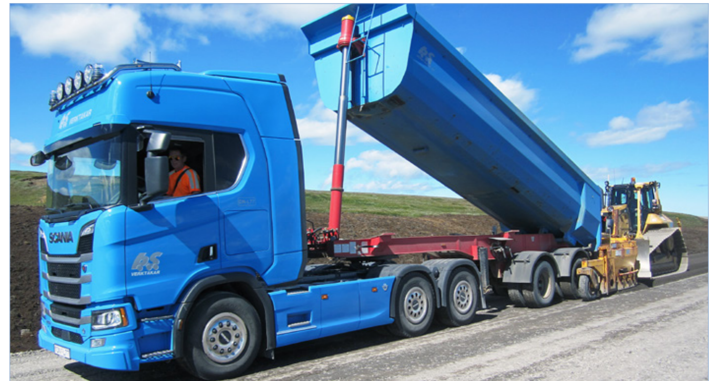
Dettifossvegur (862), efra burðarlag lagt út, 22. júní 2018.
