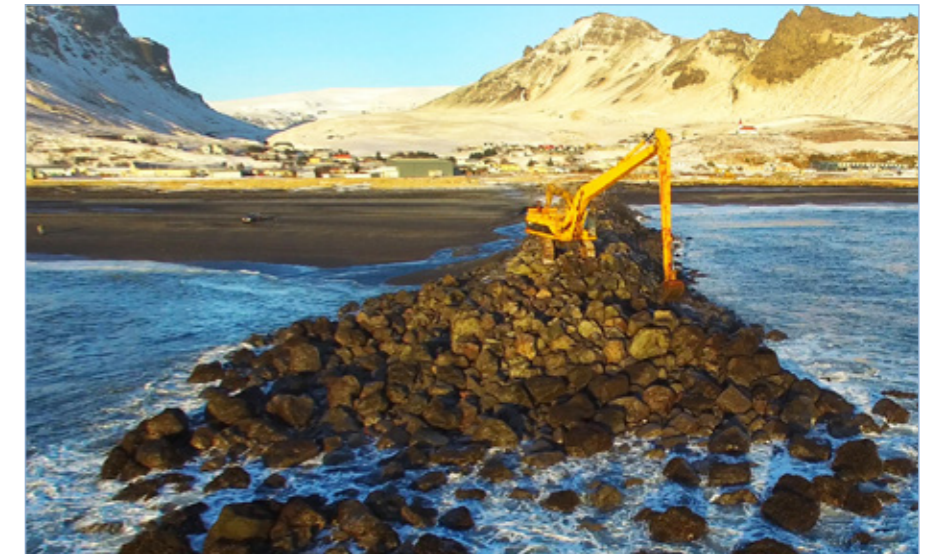
Unnið við sandfangara við Vík í Mýrdal, 20. janúar 2018. Ljósmynd Þórir N.K.
