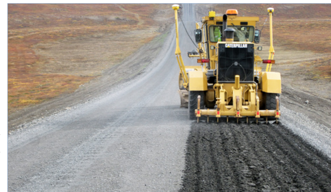
Kísilvegur (87), undirbúningur fyrir klæðingu, 10. september 2018.
