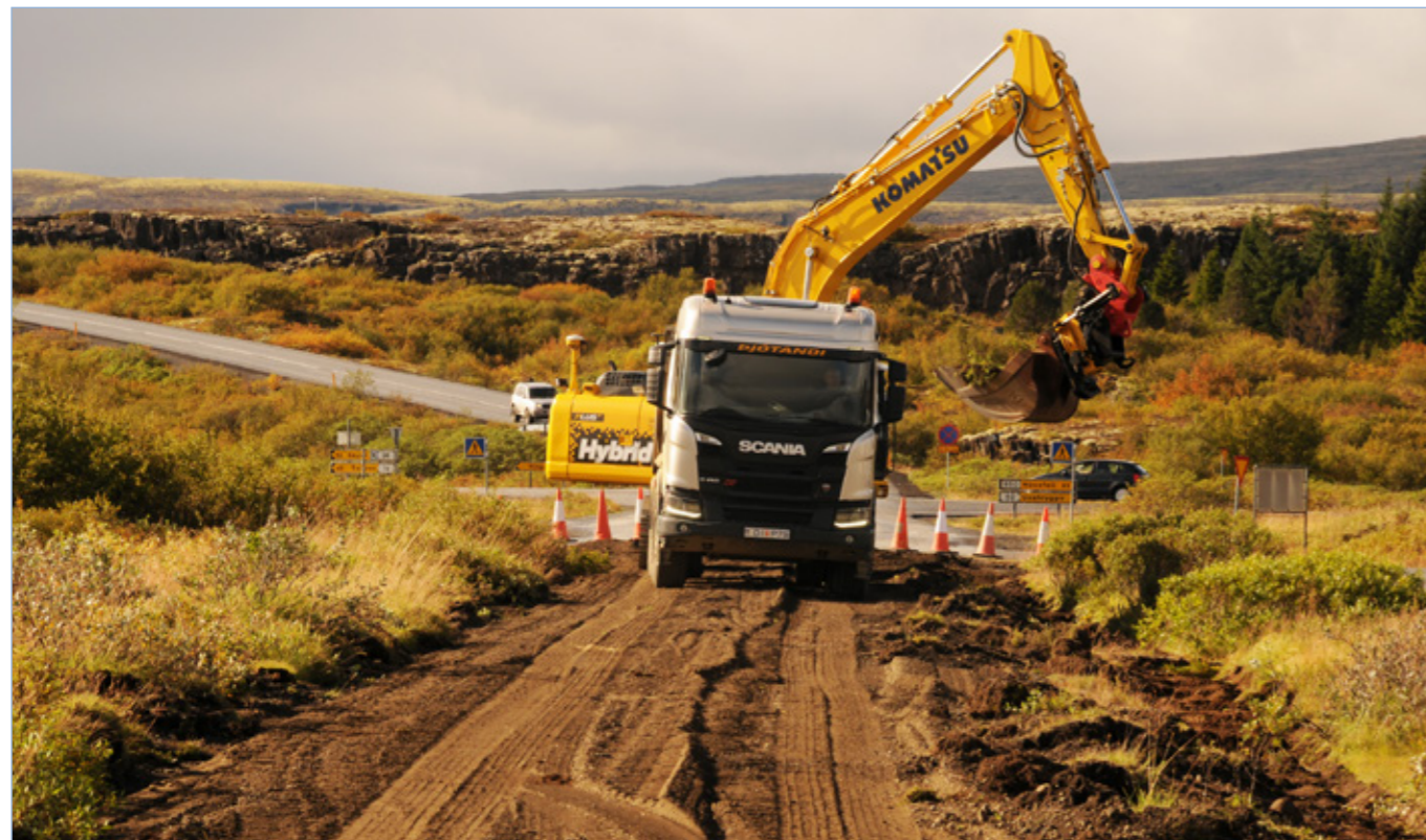
Þingvallavegur (36), endurbygging við þjónustumiðstöð, 12. september 2018.
