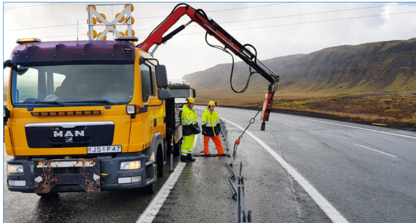
Hringvegur (1), Suðurlandsvegur, gert við víravegríð í Kambabrekku, 25. september 2018.
