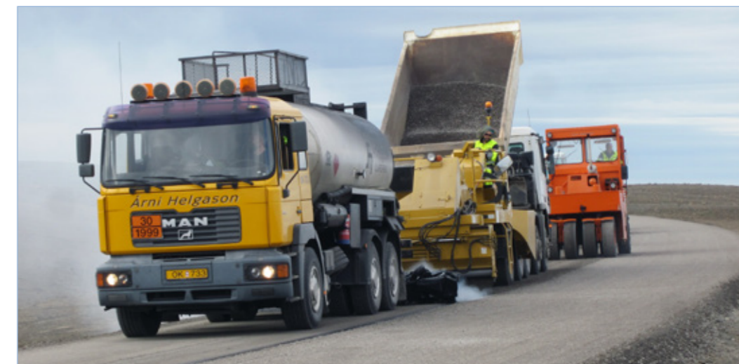
Dettifossvegur (862), klæðing, 28. júní 2018.
