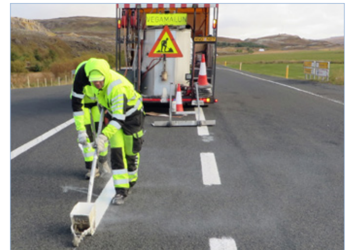
Hringvegur (1), vegamót við Vestfjarðaveg (60), yfirborðsmerkingar, 19. september 2018.
