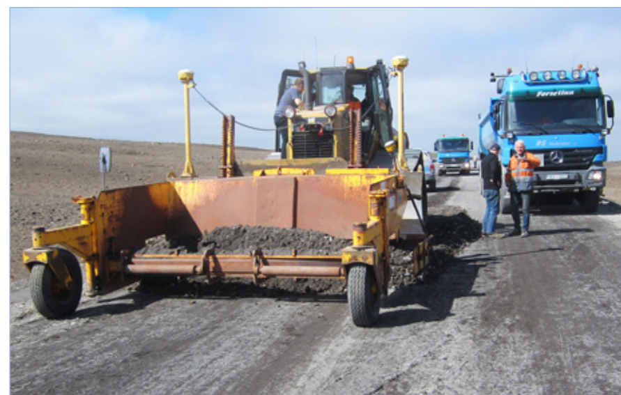
Dettifossvegur (862), efra burðarlag lagt út, 7. júní 2018.
