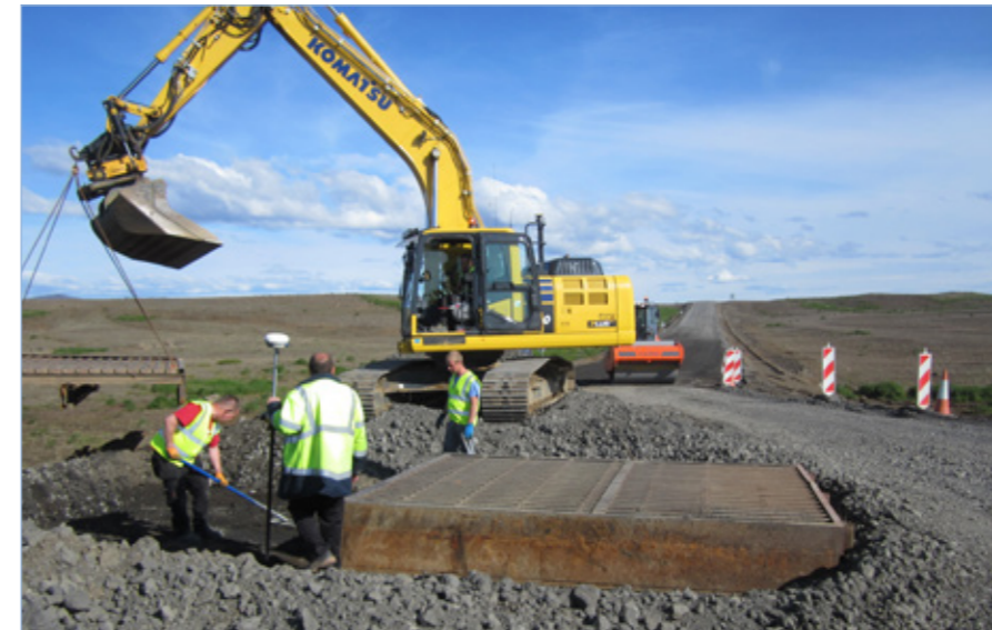
Kísilvegur (87), ristarlið sett niður, 27. júlí 2018.
